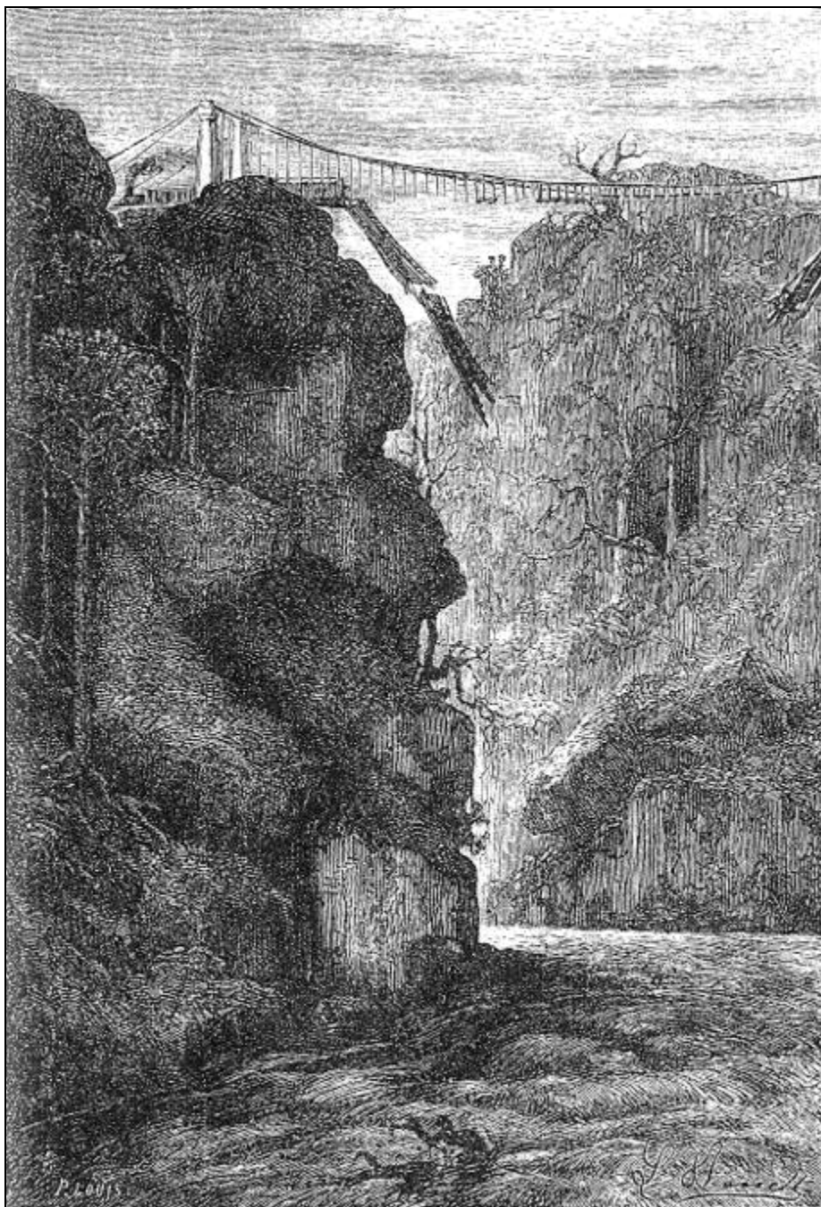
Le pont, définitivement ruiné, s'abîmait avec fracas.
